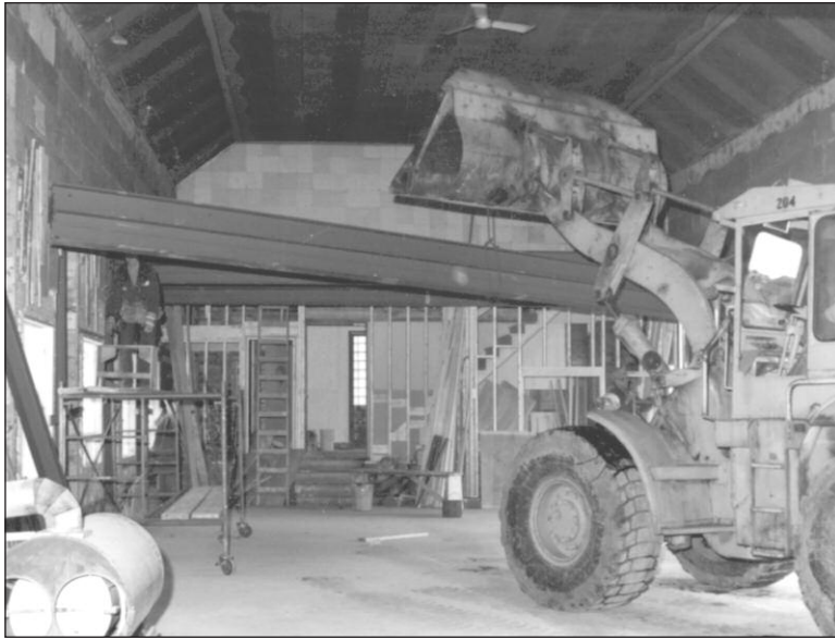
Travaux de transformation du Clarence.
